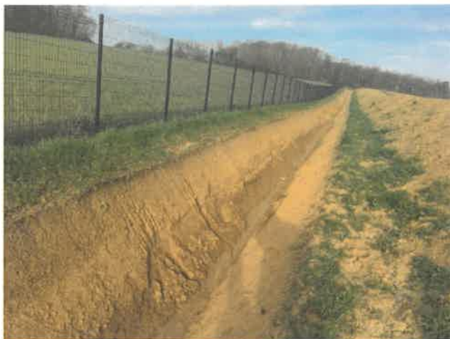
Photographie du fossé réalisé en tête du talus et destiné à assurer la reprise des eaux issues du bassin versant situé en amont
